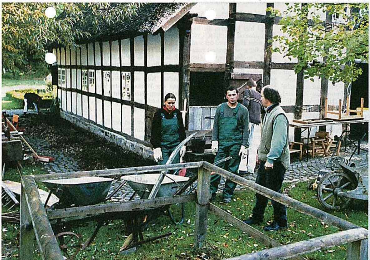
Sanierungs-Jobs: Arbeiten an der Rührupsmühle gehörten zum Programm der Qualifizierungs-Maßnahme.
