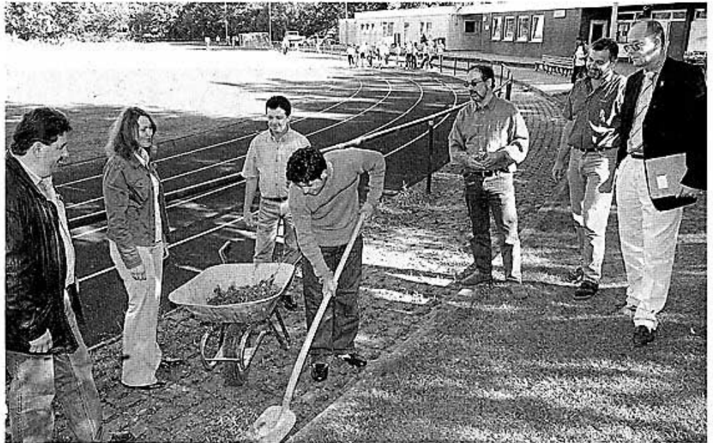
Im Einsatz: Das Albert-Pürsten-Stadion gehört zu den Bereichen, die von der Euwatec aufgewertet wurden. Davon überzeugten sich auch Vertreter von Stadt und Kreis.
