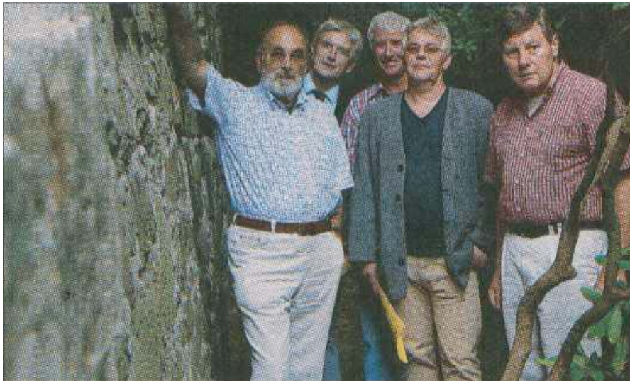
Wieder stabil: Karl-Heinz Richter, Thomas Deckel, Ernst-Antonius Paulussen, Gerhard Schmidt-Wittenbrink und Martin Bracht (Euwatec, von links) vor der sanierten Mauer.
