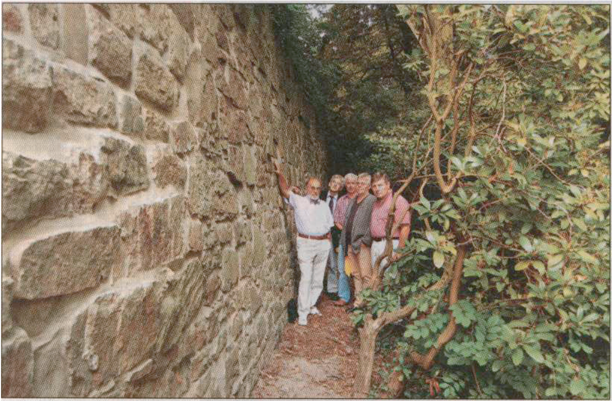
Begutachtung der gelungenen Sanierungsarbeiten (von links) Karl-Heinz Richter, Thomas Jeckel (Netzwerk Lippe), Ernst-Antonius Paulussen, Gerhard Schmidt-Wittenbrink (euwatec) und Martin Bracht (euwatec). Foto: Böke
