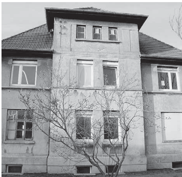
„Villa Beermann“: Nach Umbau und Renovierung wird das Gebäude für die Zwecke des Ziegelei-Museums genutzt.
