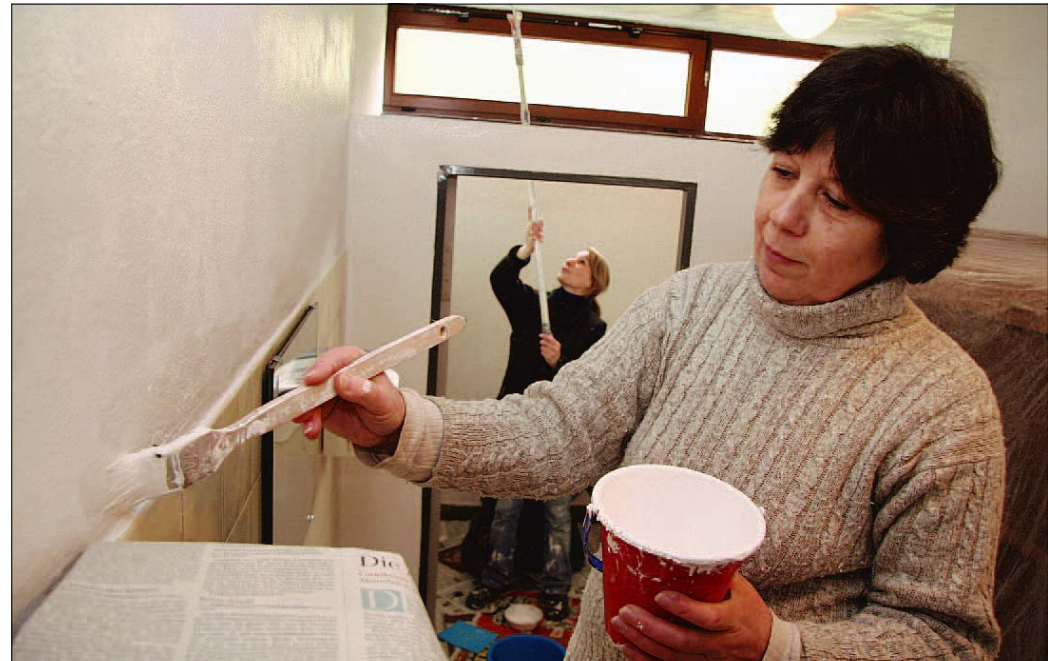
Weiß statt Grau: Larisa Gorbounova sorgt im Toilettenraum der alten Schule für frische Farbe. Im Hintergrund streicht Sarah Koschany die Decke.
