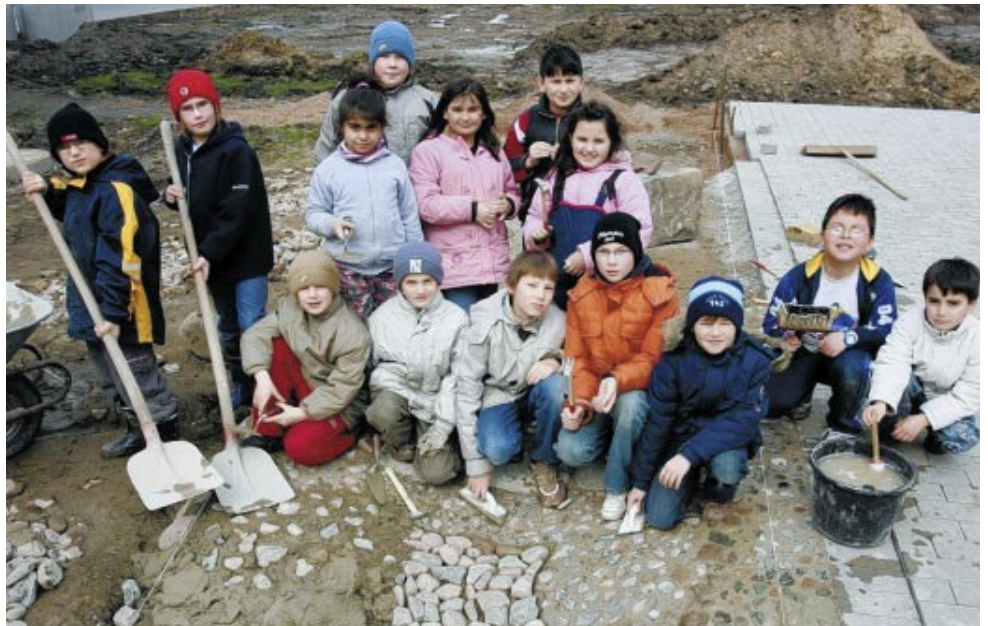
Fleißige Handwerker: Mädchen und Jungen des Viertels rund um die Michaelskirche helfen seit einigen Tagen den Männern der Euwatec beim Bau des kleinen Wasserlaufes auf dem Tannenberglplatz.
