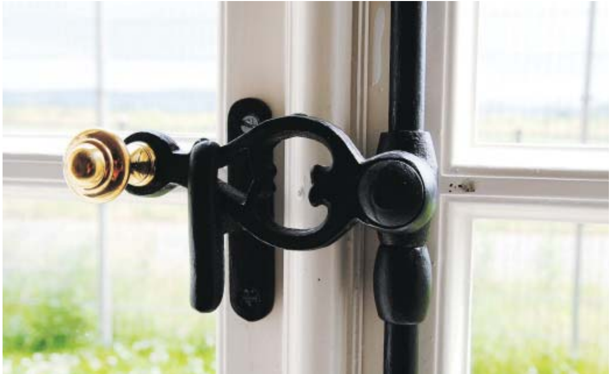
Alte Öffner mit neuer Messingkugel: Viele Fenster der Villa wurde neu aufgearbeitet und mit historisch getreuen Griffen sowie Drehstangen versehen. FOTOS: GRÖNE
