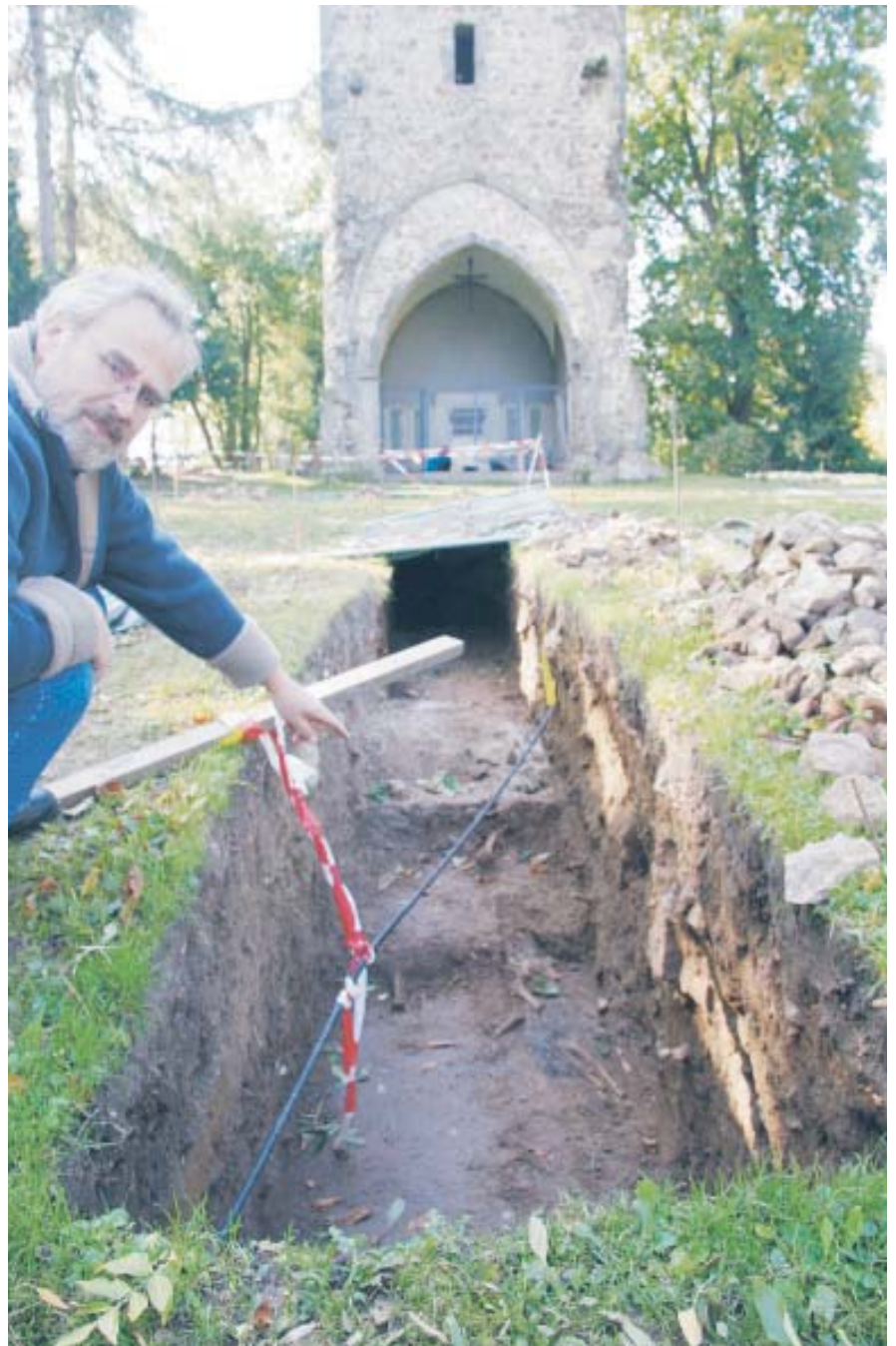
Das Graben hat sich für Dr. Hans-Otto Pollmann gelohnt: Auch in diesem rund 1,30 Meter tiefen Schacht fanden die Archäologen und ihre Helfer allerletzte Reste der Grundmauern des Kirchenschiffs, das im 13. Jahrhundert erbaut wurde. Im Hintergrund der heute noch stehende Turm. FOTO: REINEKE
