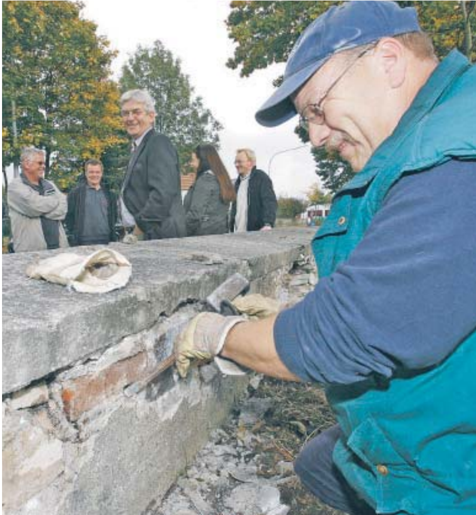
Hartes Gestein: Vorarbeiter Claus Wegehaupt meißelt den Putz von der Mauer. Im Hintergrund: Thomas Jeckel (Mitte) und Dirk Tornede (rechts).
