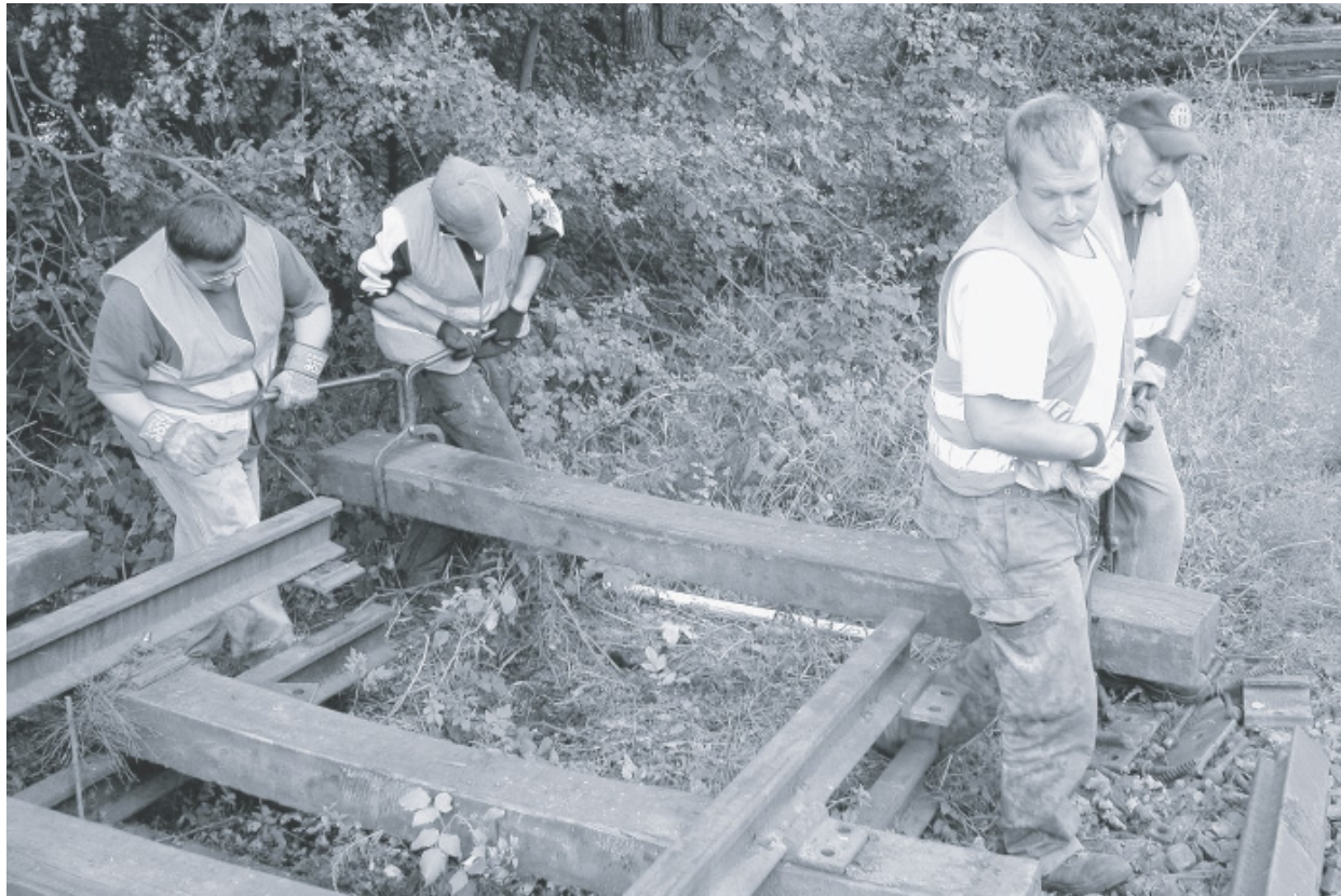
Teamwork: Peter Karsten, Manuel Rothhardt, Jens Appel (alle Euwatec) und Fritz Schneider (Landeseisenbahn Lippe, von links) transportieren eine alte Holzschwelle ab. Und die hat ein ordentliches Gewicht. FOTO: SÖLTER
