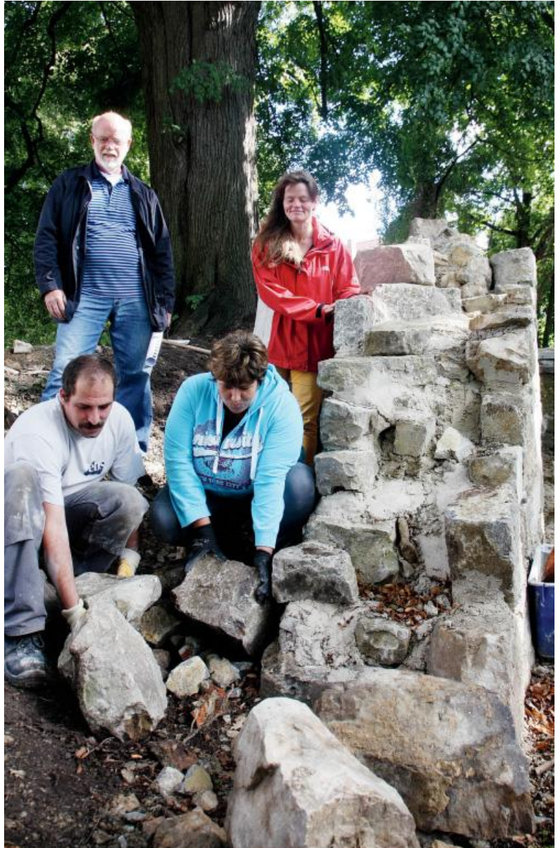
Schwere Brocken: Die Euwatec-Mitarbeiter Sascha Mellies und Regina Kirsch gehen in die Knie, um einen großen Stein hochzuheben. Hinter ihnen schauen sich Lothar Kaup und Brigitte Fenner die Sanierung des historischen Gemäuers an.
