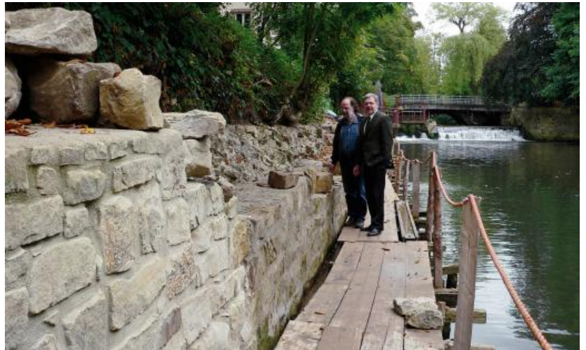
Alte Steine an der Bega: Bürgermeister Dr. Reiner Austermann (rechts) und Immo Henneberg von „Straßen und Entwässerung Lemgo“ besichtigen die sanierte Mauer am Hohen Wall. FOTO: PRIVAT
